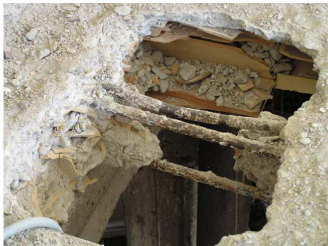
Figura 5.1.4.2 – Particolare travetti solaio
