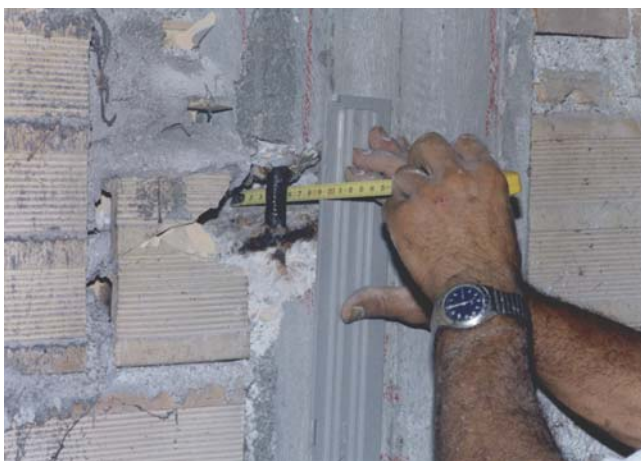
Figura 6.1.3.3 – controllo dei copriferri (Foto fornita dall'ing. M. Scansani)
