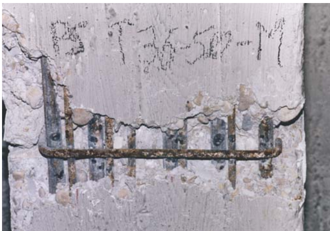
Figura 6.1.3.8 – Armature di una trave in mezzeria (Foto fornita dall'ing. M. Scansani)
