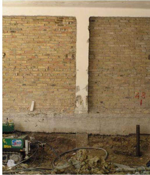
Figura 5.1.8.2 – murature nel piano s.interrato
