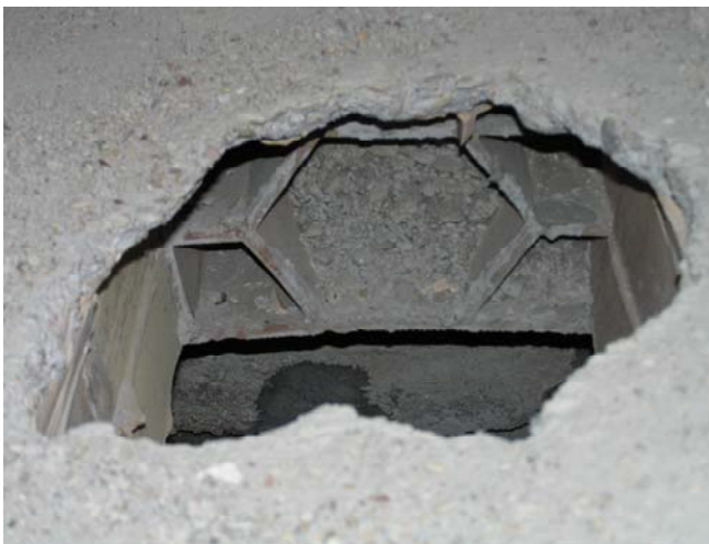
Figura 5.1.4.1 – Pignatte presenti nel solaio
