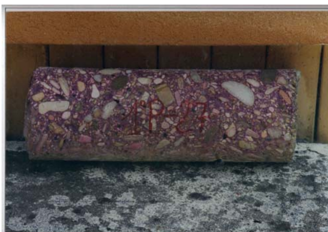
FOTO 8 Campione di calcestruzzo 1P-27 Prova di carbonatazione del calcestruzzo eseguita sulla "carota" individuata con il rif. 1P-27 e prelevata nel pilastro n. 27 posto al Piano Primo (cfr. fig. 3). Tutto il campione di calcestruzzo ha assunto una colorazione violacea, manifestando dunque l'assenza di carbonatazione.
