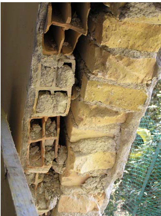
Figura 5.1.8.3 – La tamponatura esterna
