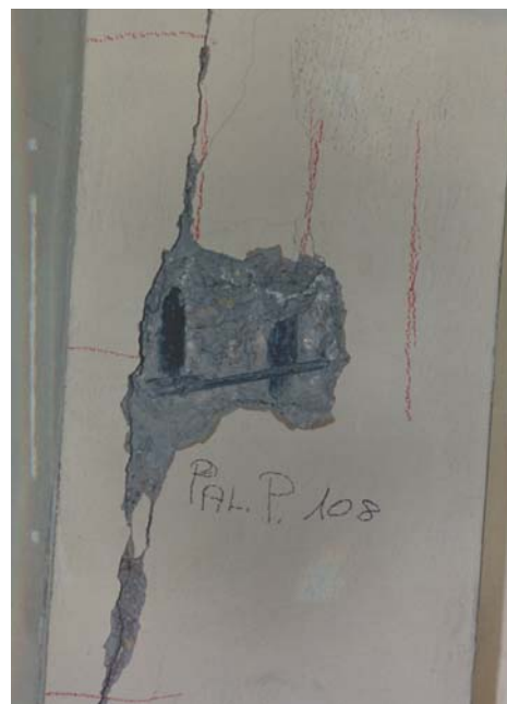
Figura 6.1.3.4 – saggio diretto (Foto fornita dall'ing. M. Scansani)
