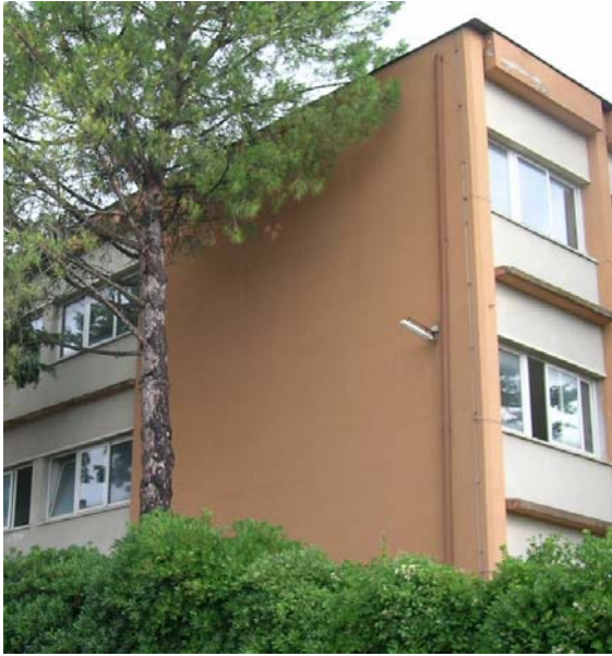
Figura 5.1.8.1 – foto del setto murario
